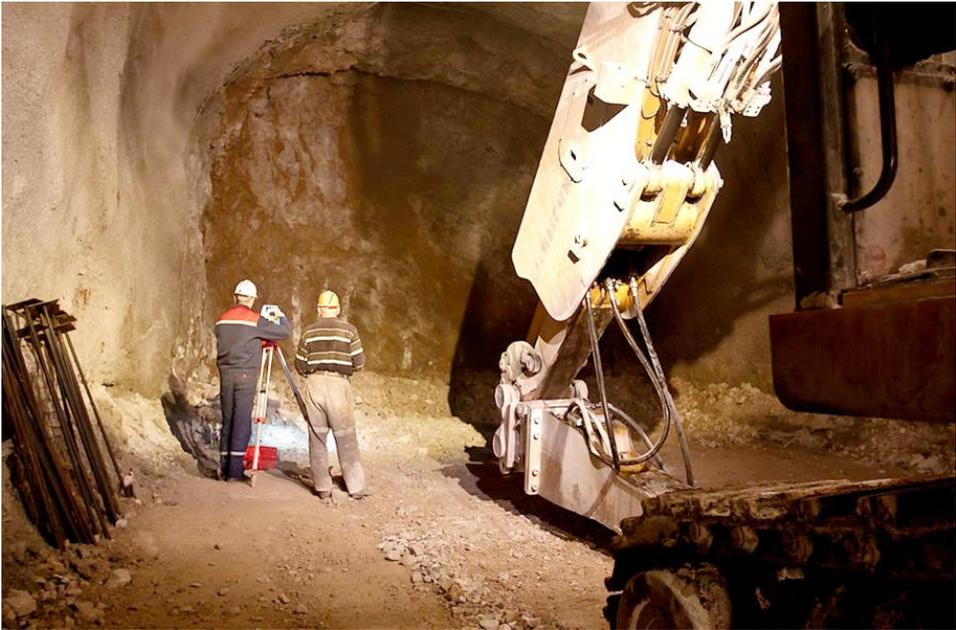
Рисунок 1 – Отбойно-оборочный агрегат на проходке туннеля на Сицилийской автостраде
