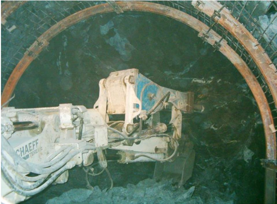
Рисунок 2 – Отбойно-погрузочная машина на проходке выработки на шахте Донского ГОКа
