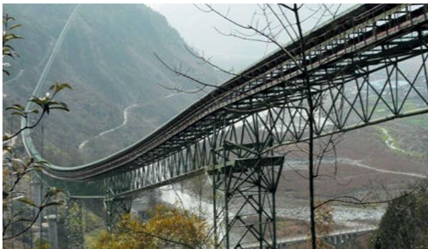
Рисунок 1 – Магистральный ленточный конвейер для транспортировки вскрышных пород
