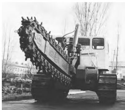
** Цепная камнерезная машина ЦКМ-1
